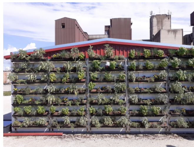
59. Modularna urbana farma sa zelenim krovom, zelenim zidom, akvaponskim sustavom i solarnim panelima, na lokaciji Sljeme Sesvete, realizirana u sklopu EU projekta proGReg
