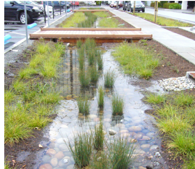
Slika 38. Održivi sustavi odvodnje infrastrukturne površine
