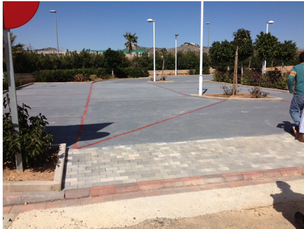
Slika 62. Parkiralište od poroznog asfalta, Benaguasil
